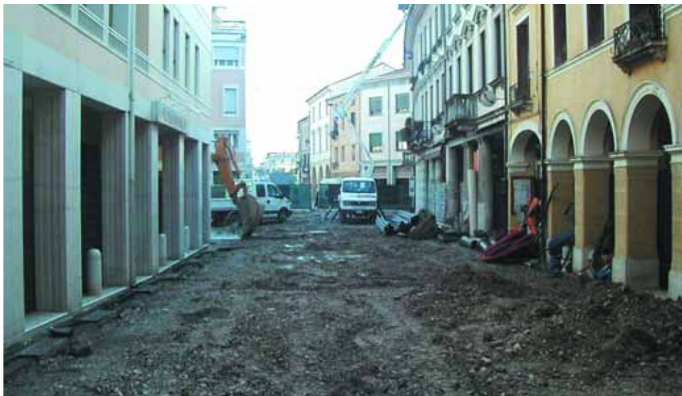
Piazza Luzzatti al tempo dei lavori
