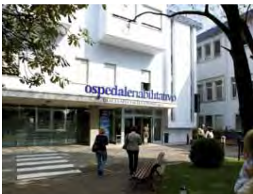
L'ingresso dell'ospedale riabilitativo di Motta
